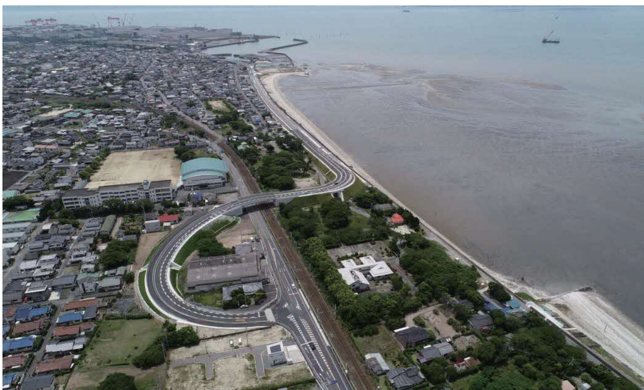
(都)長洲玉名線(長洲町:幹線街路)
