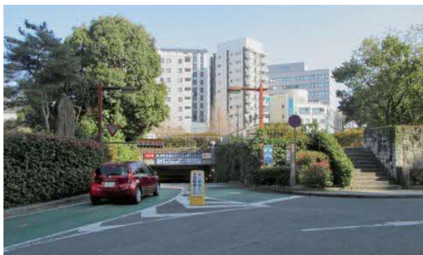
辛島公園地下駐車場(熊本市)
