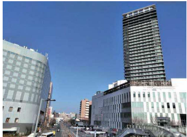
熊本駅前北地区・熊本駅前東A地区(熊本市)
