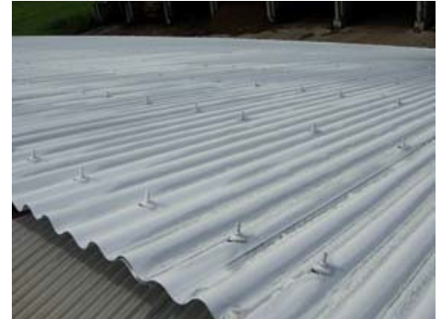
石灰塗布後の屋根
