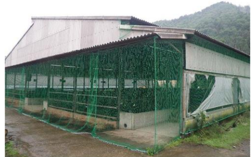
写真2 防鳥ネットの設置例
