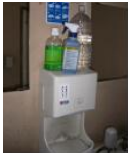
手洗い場の設置
