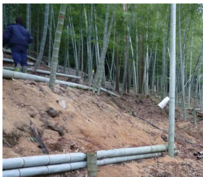
土留め材料として有効利用
