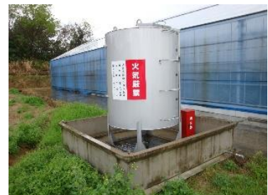
防油堤の設置
