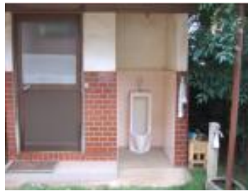
トイレの整備
