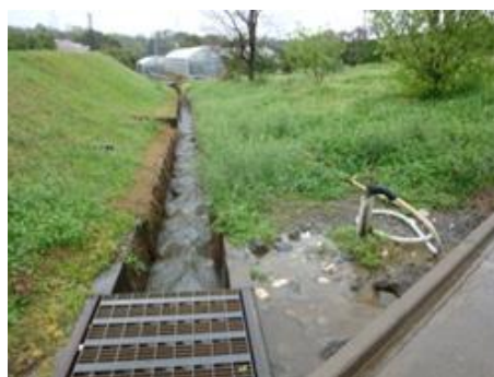
水路やバルブの確認
