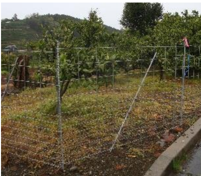
侵入防止柵の設置
