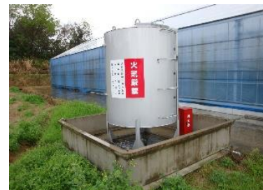
防油堤の設置
