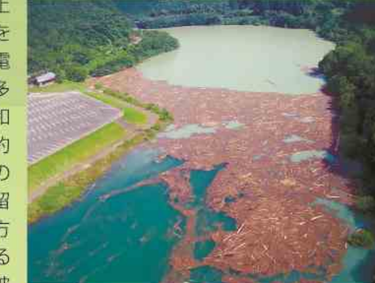
捕捉した流木の状況
