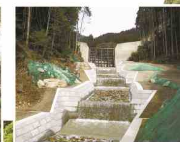
北目川砂防堰堤(水上村)
