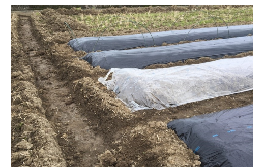
図1 排水溝の設置の様子
