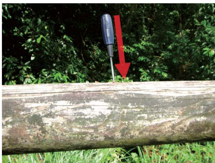
写真-4 被害状況写真（被害度 1）
