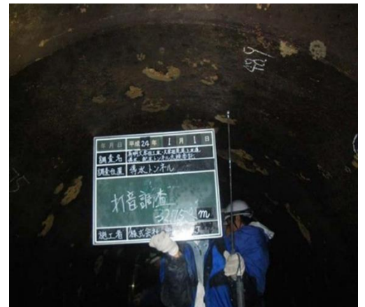
平成23年度トンネル内部点検時の状況
