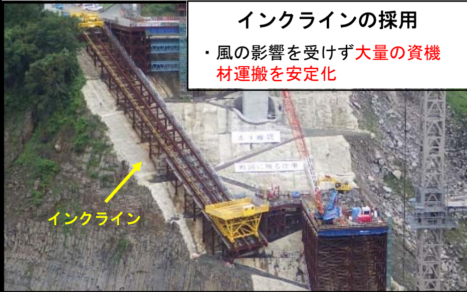
下部工施工時
