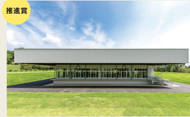
再春館製菓所体育館サクラリーナ(上益城郡益城町)
