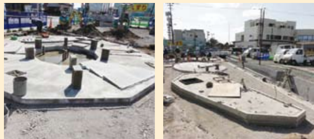
※写真は3月上旬の施工状況。
