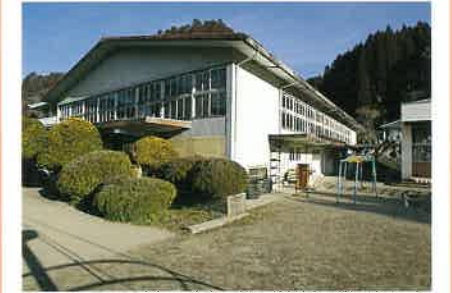
老朽化が激しく建て替えが決まっている体育館。建て替え用地は検討中だ
