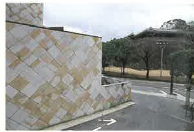
熊本城の石垣と対峙する魅力ある合津石の外壁
