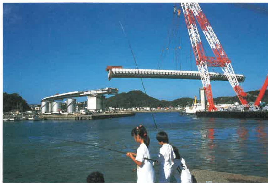
橋桁をクレーンで吊り上げて組み立てる
