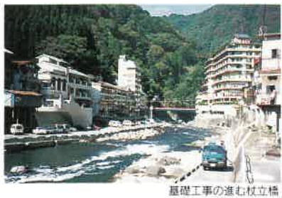
基礎工事の進む杖立橋
