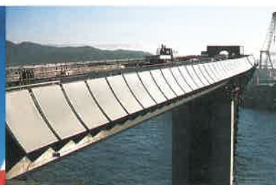
フラップ（風よけ板）によって歩行者を風から保護すると同時に、橋全体が揺れないようになっている
