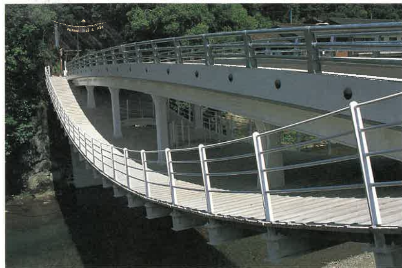
馬見原橋。通常の道（上部）と歩行面（下部）との二重構造になっている
