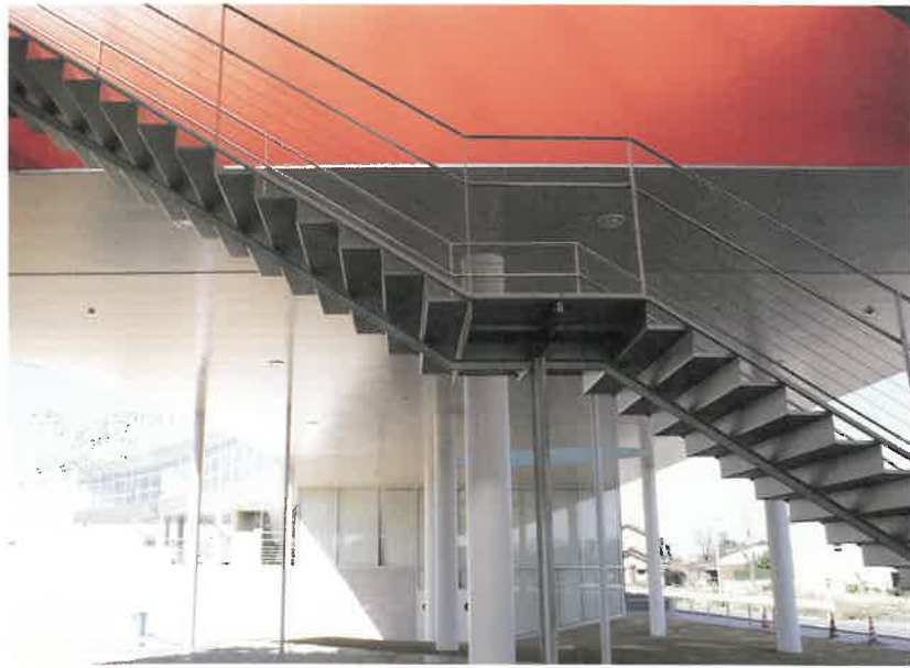
消防署の建物へは真下から、階段を上って入る
