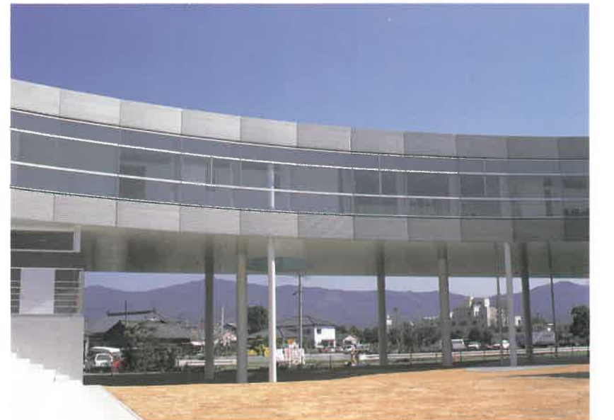
建物をピロティで持ち上げ、地上を開放した
