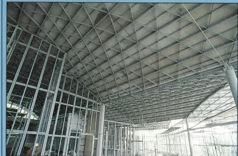
●発行-くまもとアートポリス事務局 熊本県土木建築課内 熊本市水前寺6-18-1 tel 096-383-1111 (内線6220 / 6221) ●編集-くまもとアートポリスコミッショナー事務局 東京都渋谷区渋谷2-5-7 本間ビル 建築・都市ワークショップ内 tel 03-407-4753 全貌現わす八代市立博物館 内部から見た屋根骨組み(下) 設計/伊東豊雄
