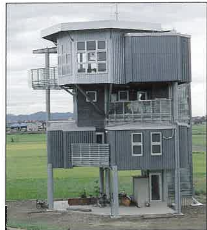
今年になって竣工した住宅
