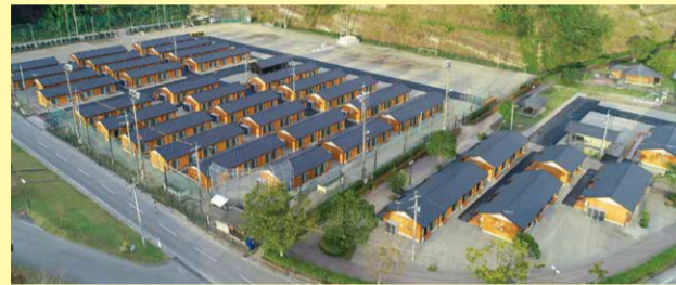
球磨村グラウンド仮設団地
