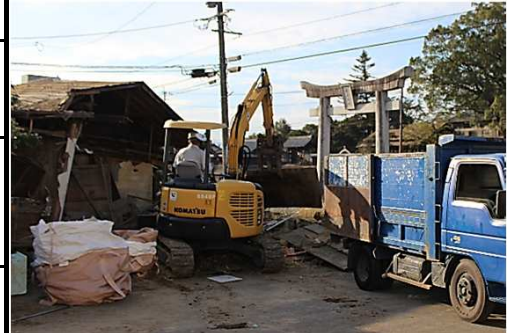
解体工事の様子 (青井阿蘇神社前)
