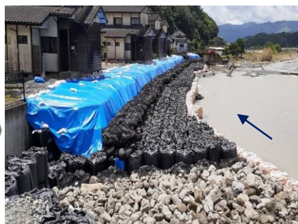
応急復旧後 (R2. 7月20日時点)
