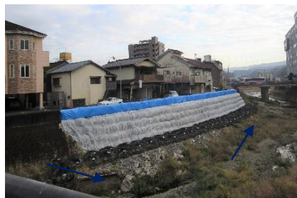
応急復旧後 (R2. 7月20日時点)
