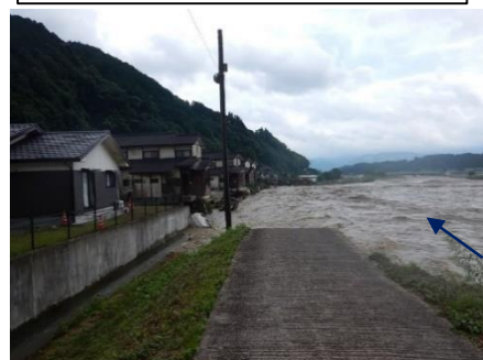
被災状況 (R2. 7月4日時点)
