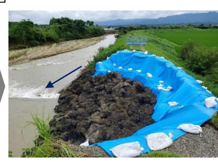
応急復旧後 (R2. 7月15日時点)
