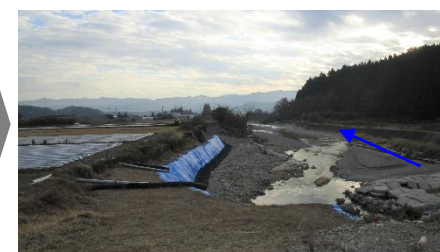
応急復旧後 (R2. 7月17日時点)
