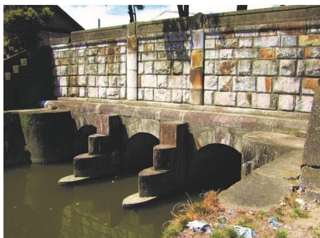
11 . 郡築二番町樋門(斜めより撮影)
