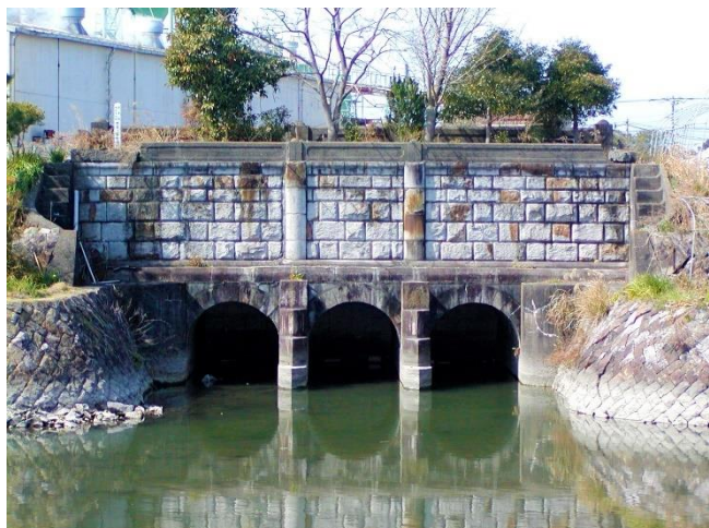
11 . 郡築二番町樋門(正面)
