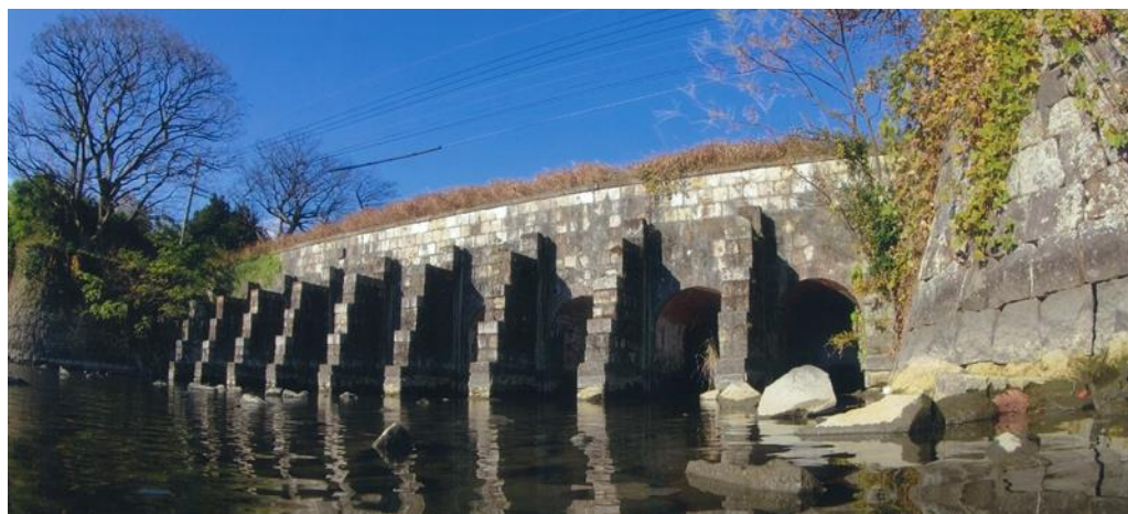
10. 旧郡築新地甲号樋門 附・潮受堤防
