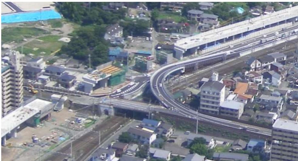
仮陸橋へ切替え（平成20年6月頃）
