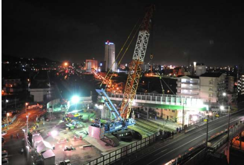
仮陸橋架設工事（平成20年 1月）
