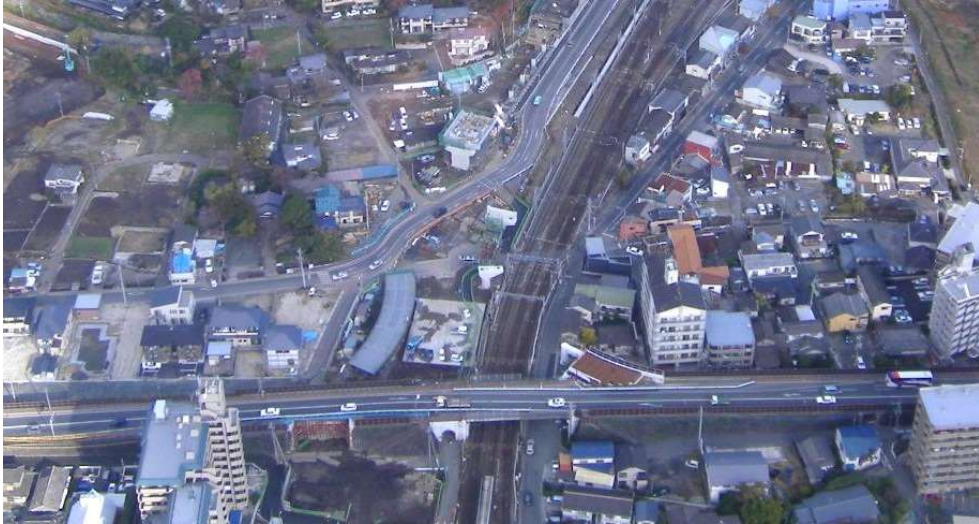
田崎陸橋 撤去前
