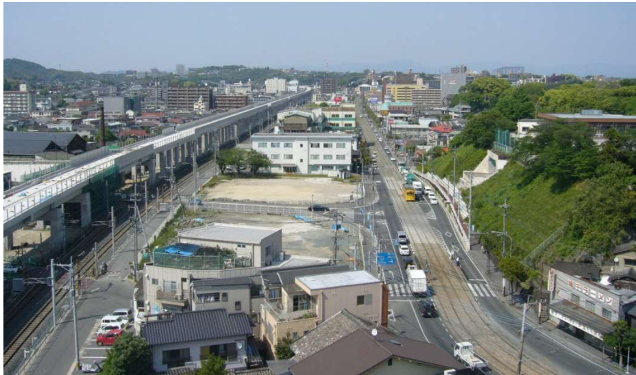
段山陸橋 撤去時（平成21年5月頃）
