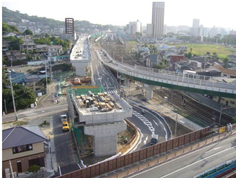
仮陸橋へ切替え（平成20年 6月）
