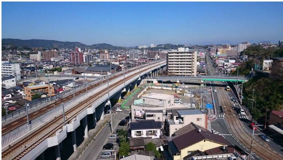
段山陸橋 復元後（平成27年11月頃）
