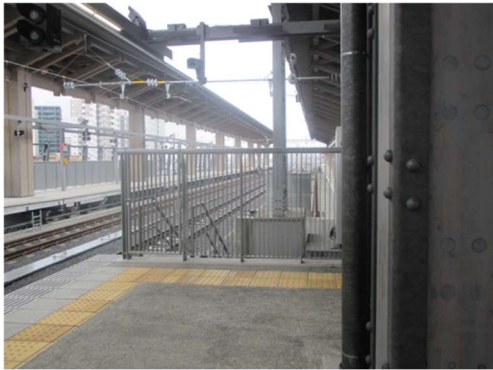
転落防止柵・柱の面取り
