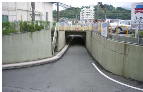
高架前；春日地下道（東→西）
