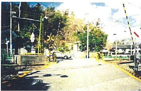
高架前；新横手踏切（東→西）
