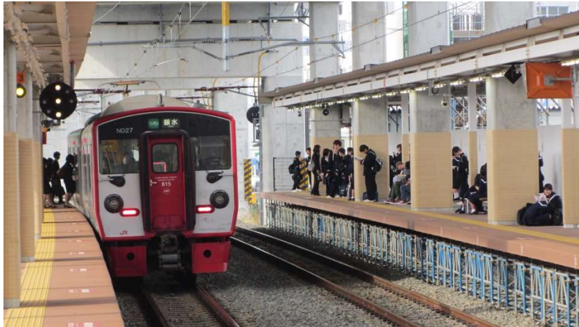
二次仮線期間のホーム（平成25年4月）
