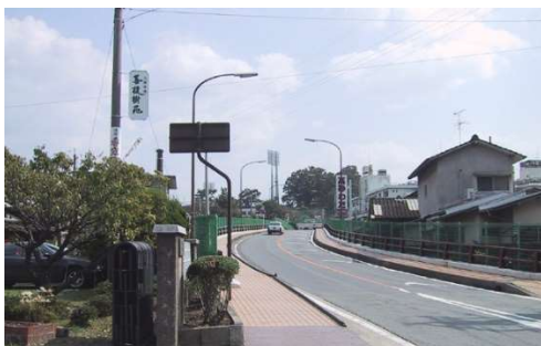
高架前；段山陸橋（西→東）
