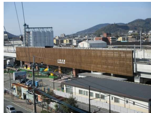
新駅舎の完成（仮駅舎供用中） （平成27年2月）
