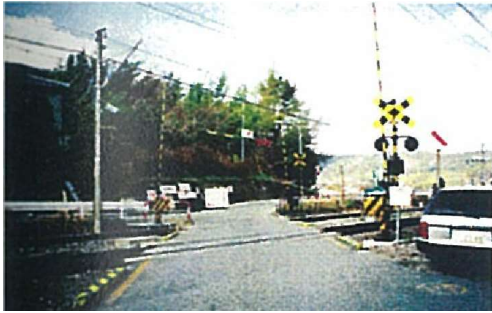
高架前；池亀踏切（東→西）
