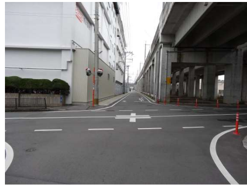
鹿児島本線側道 第14号線
