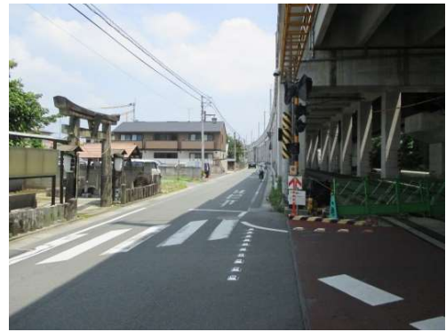
鹿児島本線側道 第 2 号線
