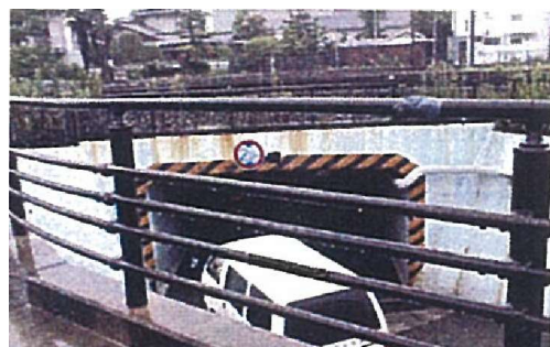
高架前；田崎地下道（西→東）
