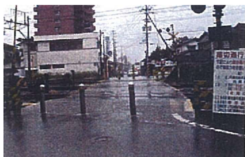
高架前；百貫踏切（西→東）
