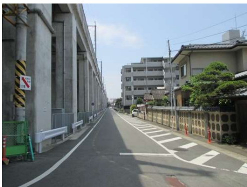
鹿児島本線側道 第 7 号線
