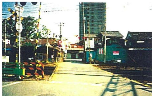
高架前；古道踏切（西→東）
