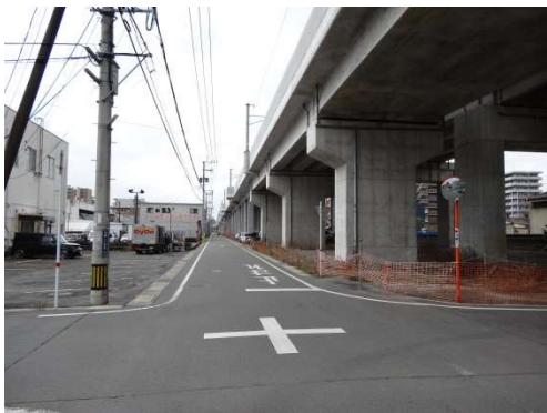
鹿児島本線側道 第11号線
