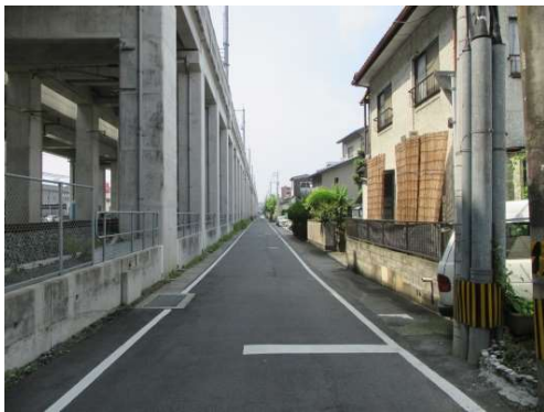
鹿児島本線側道 第13号線
