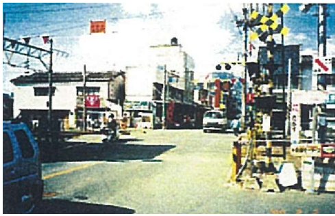
高架前；本妙寺踏切（東→西）
