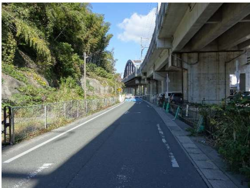
鹿児島本線側道 第 3 号線
