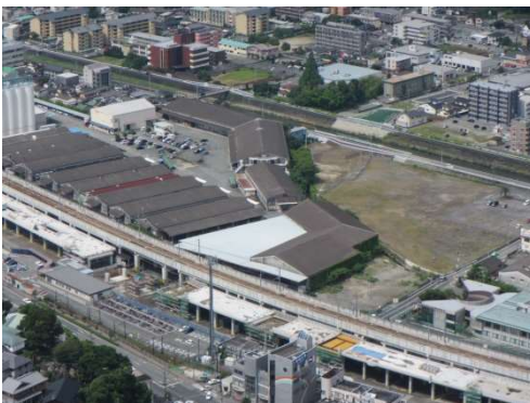
高架橋工事（平成26年7月）
