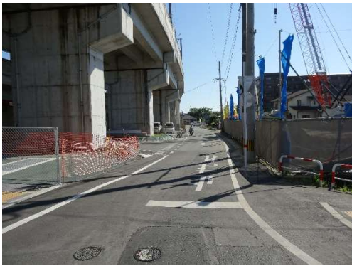
鹿児島本線側道 第 1 号線
