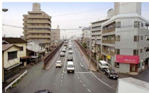
高架前；田崎陸橋（東→西）
