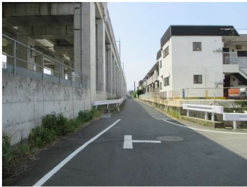
鹿児島本線側道 第9号線
