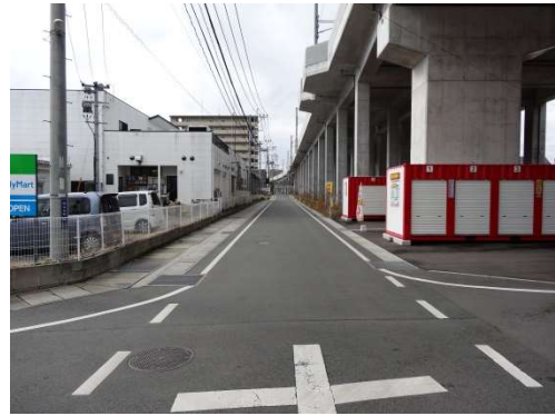
鹿児島本線側道 第10号線
