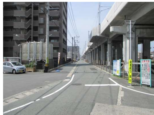
鹿児島本線側道 第12号線
