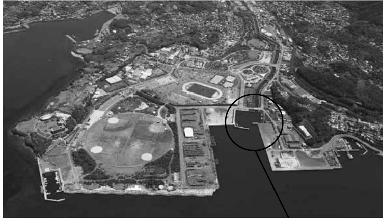
浮棧橋(現況写真)
