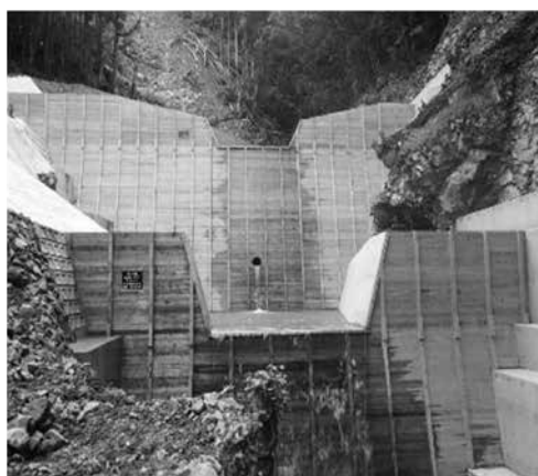
溪間工（谷止工）
