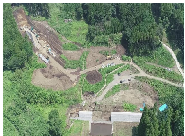
東下田川2 砂防堰堤（令和2年8月撮影）
