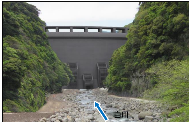
上流側からダムを望む
