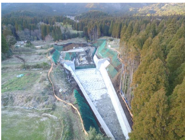
花原川1 砂防堰堤（令和2年2月撮影）
