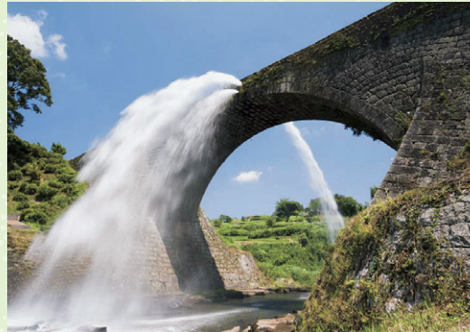
つうじゅんきょう ▲通潤橋(山都町)
