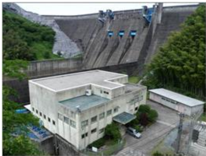
緑川ダム・第一発電所
