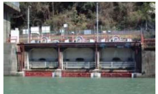
右岸側の取水口。ここで取水した水は、トンネルを通して沈砂池(麓町)に向かいます。
