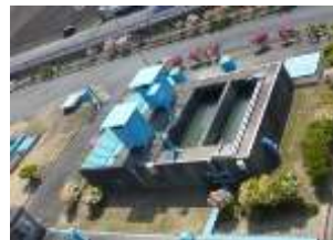
着水井・混和池
