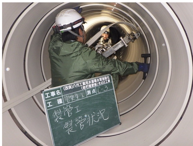
H28の製管工法(既設管の内側で、巻き立てた帯板を接合しています。)
