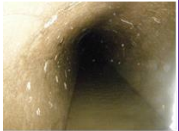
平成23年度トンネル内部点検時の状況
