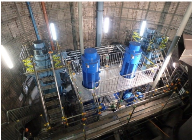
導水ポンプ更新中(真ん中の2台が新しいポンプです。両側奥の古いポンプに比べて、大分スマートになりました。)
