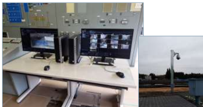
新たに設置した監視カメラ(右)とそのモニター(左)です。これで安全管理体制もバッチリ！
