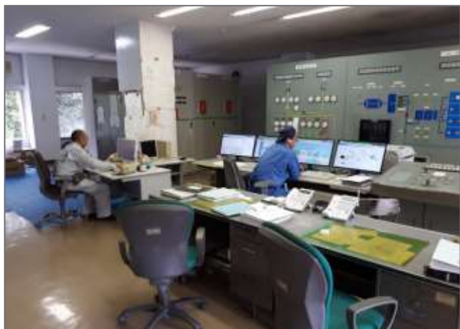
監視制御設備更新中。真ん中から右側の4台のモニター（機器は机の下）が新しい制御装置です。左側の旧モニターと奥のレトロな表示板は3月に撤去します。40年間お疲れ様！
