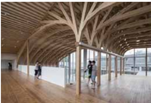
■混構造（鉄筋コンクリート造+木造） 山鹿市立山鹿小学校 オープンスペース 資料：シーラカンズK&H（株）HP より
