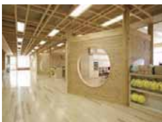
■間伐材を活用した 学校教室、共用部の事例
