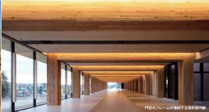
門型木フレームが連続する透析室内観
