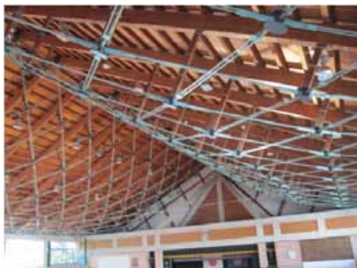
写真-3 スギ製材の重ね材と鉄筋張弦梁
