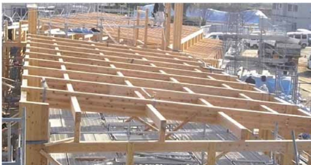
使用例：登り梁に利用されたBP材（熊本県中央家畜保健衛生所）
