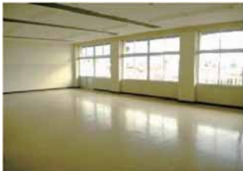
■改修前の学校の図書館
