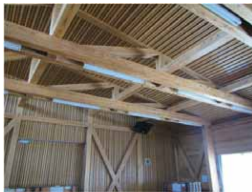
写真-4 スギ接着重ね材を使った建築物
