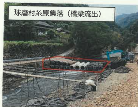
球磨村糸原集落（橋梁流出） 啓開中（潜り橋形式、出水時通行止め）
