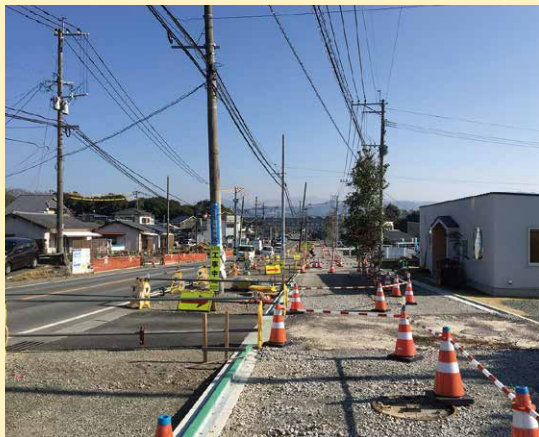
益城町広崎の工事進捗状況
