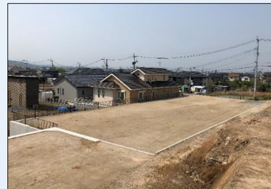
造成工事一部完了（宮園地区）
