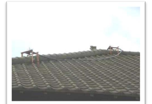
畜舎屋根へのスプリンクラー設置
