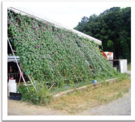
畜舎壁へのグリーンカーテン設置
