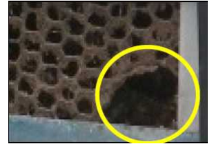
金網等の破損箇所修繕
