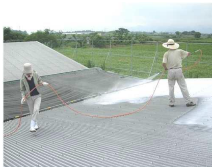
屋根への石灰の吹きつけ
