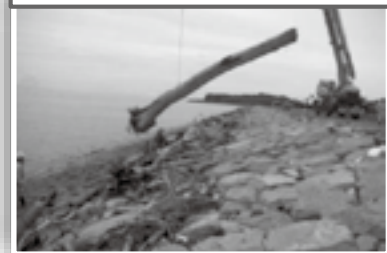
漂着流木撤去作業
