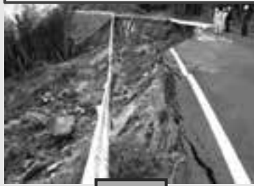
農道の復旧 (宇城市)
