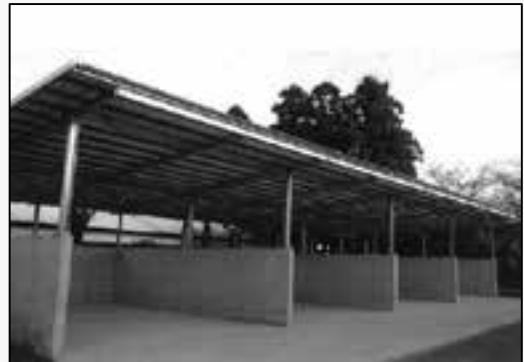
畜産クラスター事業で整備した堆肥舎（菊地市）
