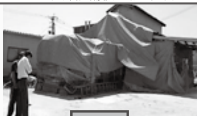
ノリ乾燥設備復旧(熊本市)
