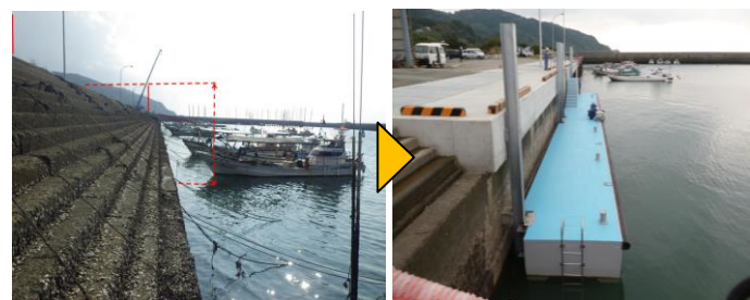
浮体式係船岸の整備（赤瀬漁港）
