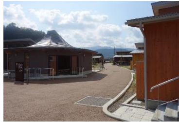
災害公営住宅（甲佐団地）
