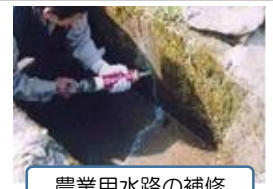
農業用水路の補修
