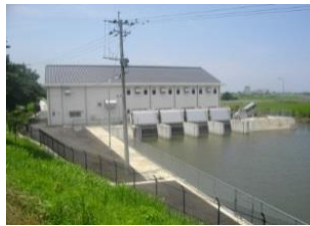
排水機場の更新
