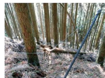
写真：ネットに木が倒れ込んだ柵
