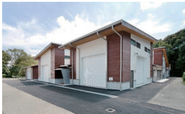
(完成した研修拠点施設)
