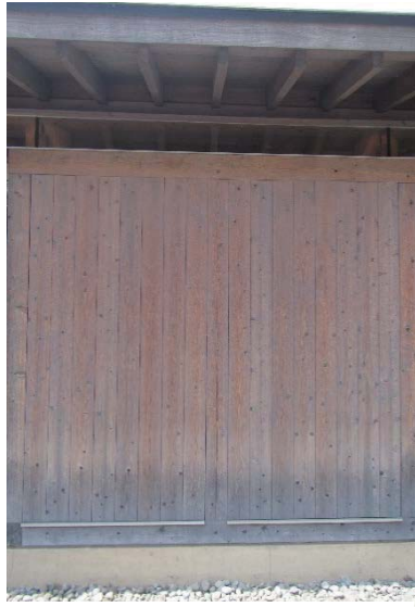
図-4 建物東面の外構材の様子
