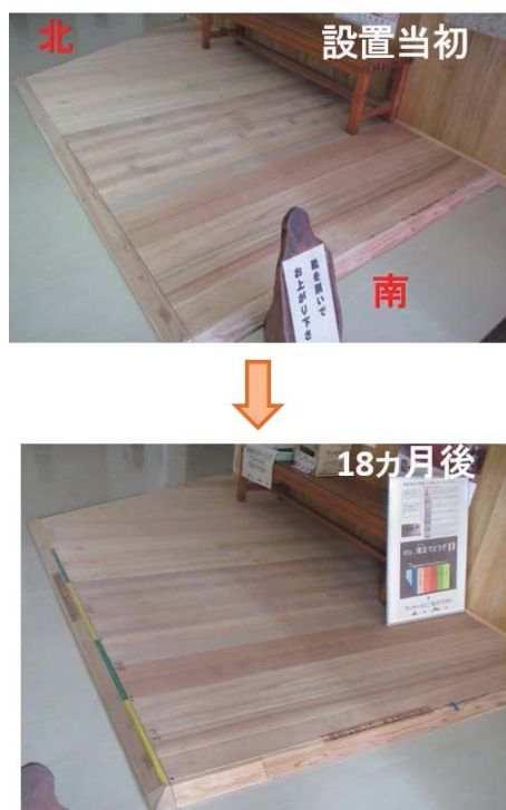
図-15 フローリング設置状況
