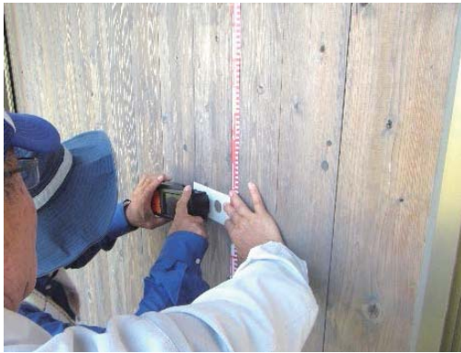
図-1 現地調査の様子
